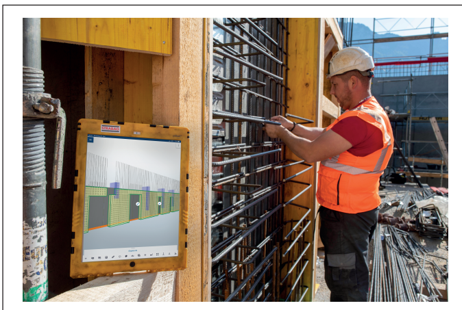
Abbildung 90: KW Schils: Anhand des Tablets werden die Bewehrungsarbeiten ausgeführt.
