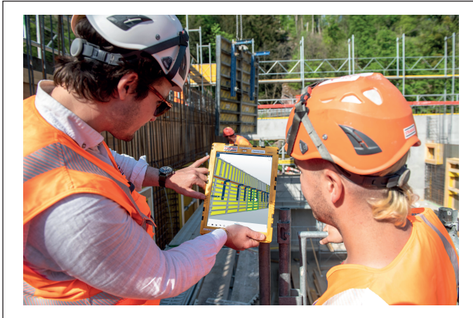
Abbildung 89: KW Schils: Bauführer und Polier bei modellbasierten Schalungsarbeiten
